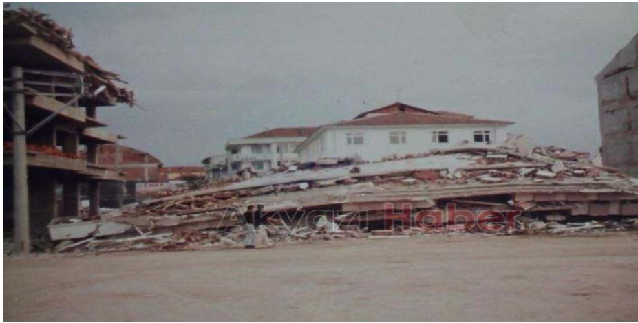
Şekil 3. 17 Ağustos 1999 Marmara depreminde Akyazı ilçe merkezinde göçen bir bina
